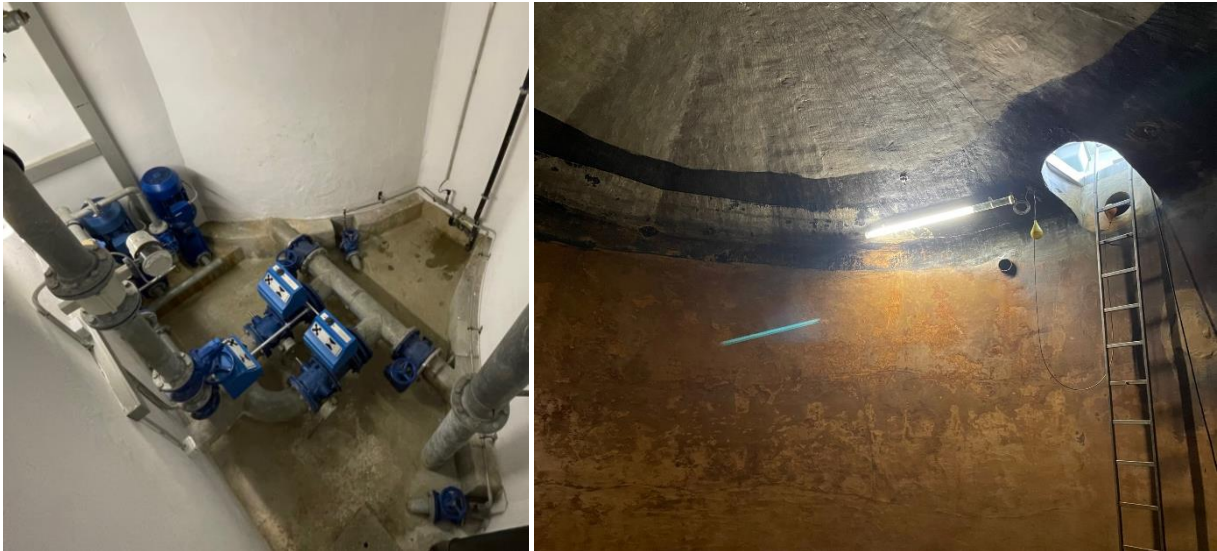
Fotos altes Reservoir Weid (links: Rohrkeller; rechts: eine der beiden Wasserkammern)
