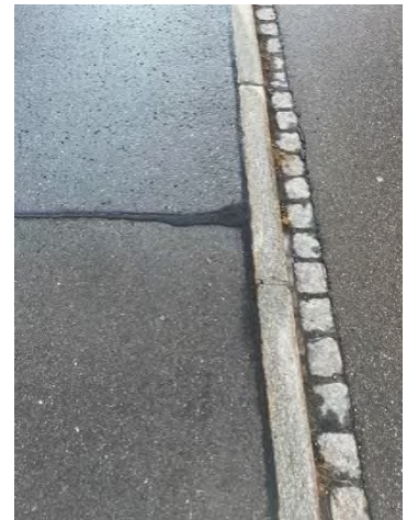
Verfugen bei Trottoirs
