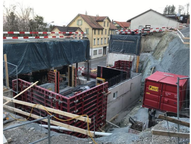
Bauarbeiten im Güetli 188 (Rollende Werkstatt AG)
